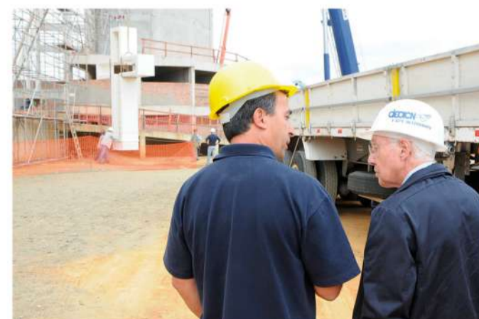
Mons. Jonas Abib junto do superintendente da Infraestrutura, Paulo Eleutério na construção do Santuário Pai das Misericórdias / Foto: Arquivo Canção Nova
