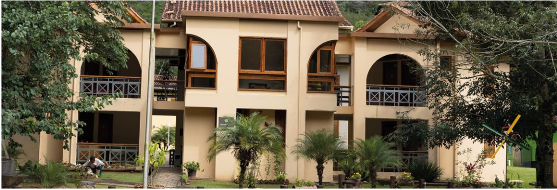
Figura: 7 - Fachada da Fazenda da Esperança Guaratinguetá – SP
