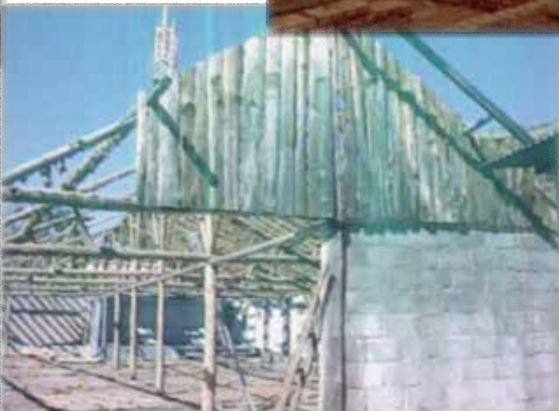
Construção do Capelão São José.
