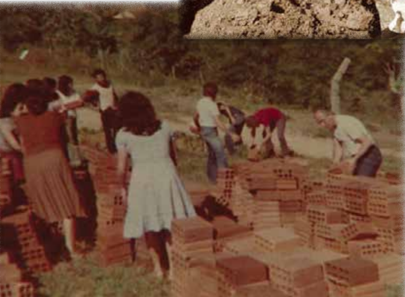
Mutirão para construção da Casa de Maria em Queluz.
