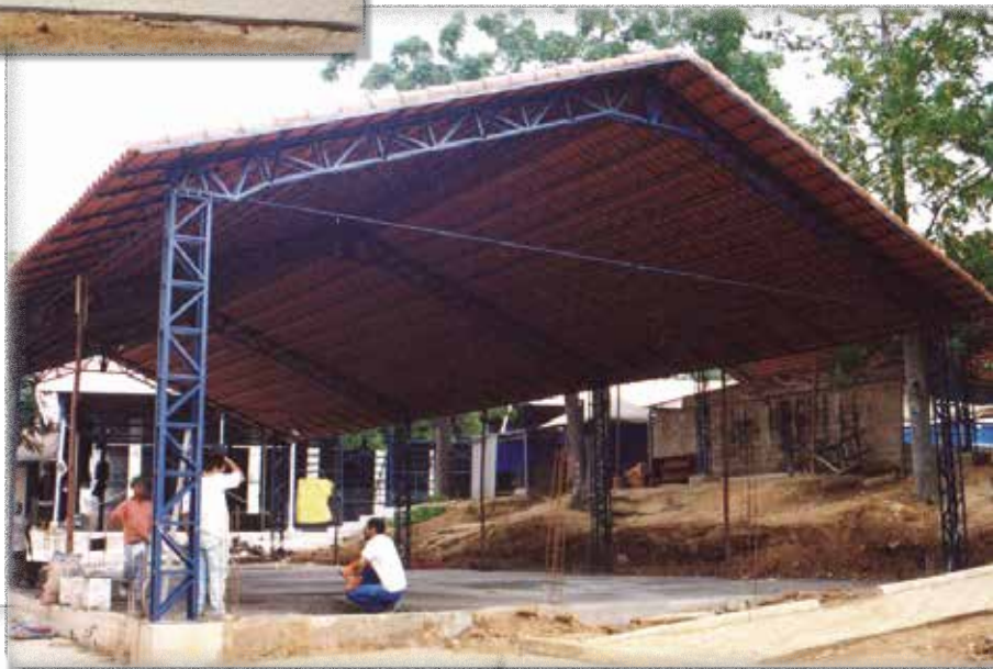
Início da construção do Rincão.
