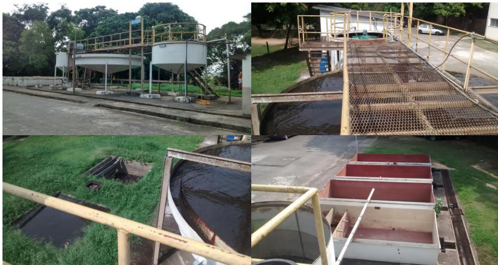
Figura 3 – Estação de Tratamento de Efluentes Fonte: O Autor (2015)
